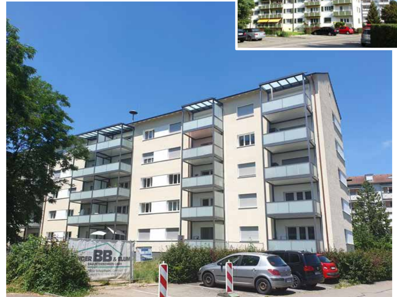
Hartmattenstraße 39-43 in Lörrach vor der Sanierung (oben), nach der Sanierung (unten)
